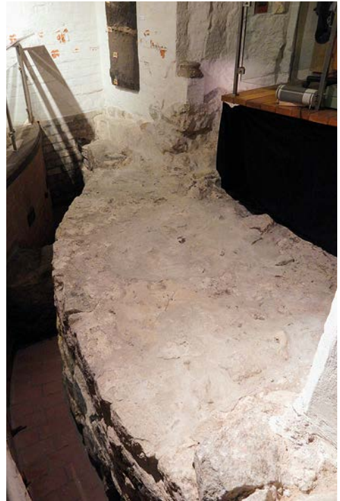
Bremen, Dom: Apsisfundament Südquerhaus
