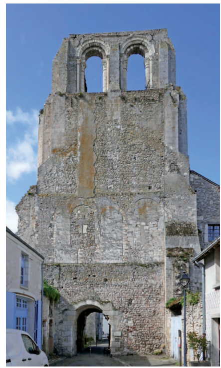
Abb. 16 Cormery, Westbau Ostseite
